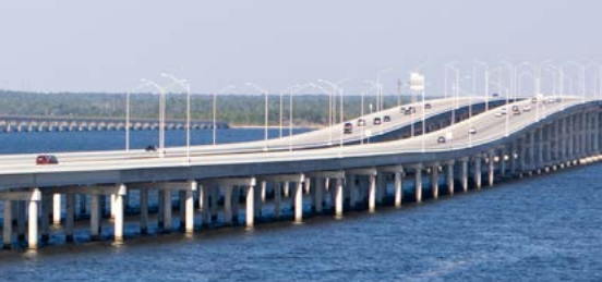
► Pensacola Bay Bridge (USA)
